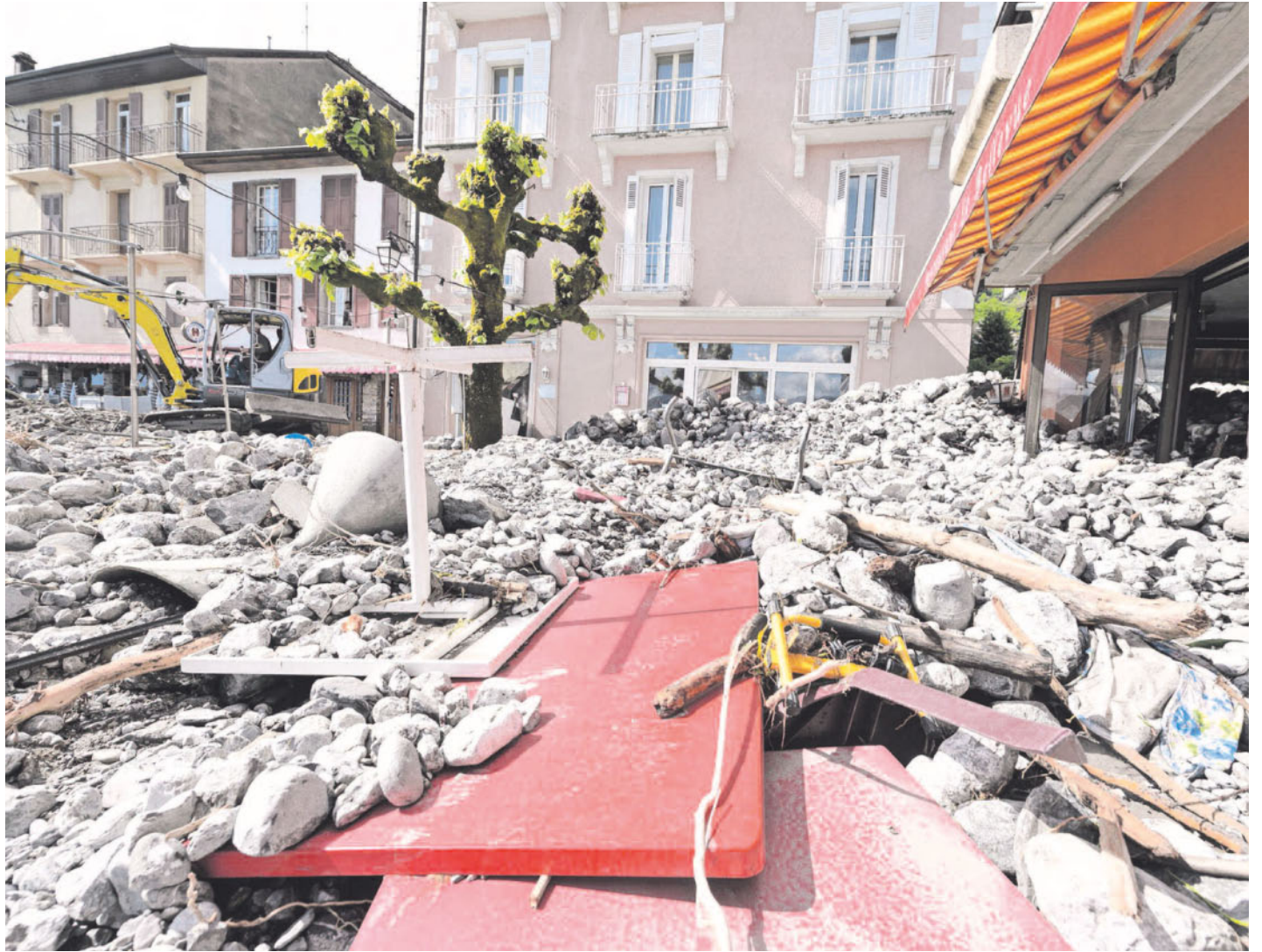
Schutt und Schlamm. Die Morge flutete St-Gingolph meterhoch.
